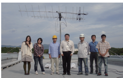
ISSと交信するための特殊な自動追尾アンテナを建設する学生とボランティアスタッフ。
